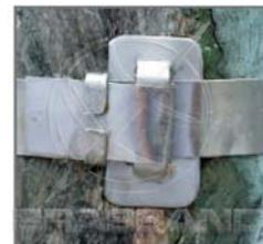
**Opção B** - Instalação completa com Fecho FEAI.
